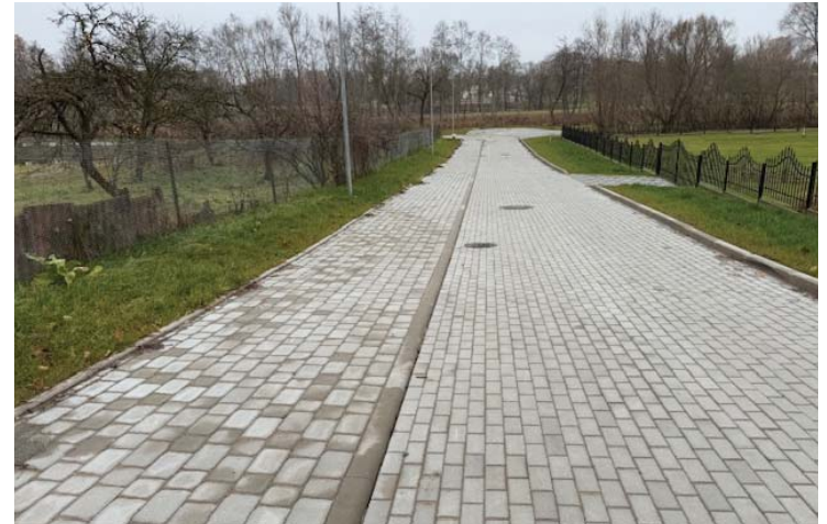
Pakalnės g. rekonstrukcija
