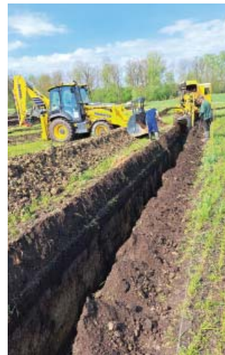
Drenažo remonto darbai Šaukavos k.
