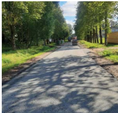
Statikų gatvės asfaltavimas
