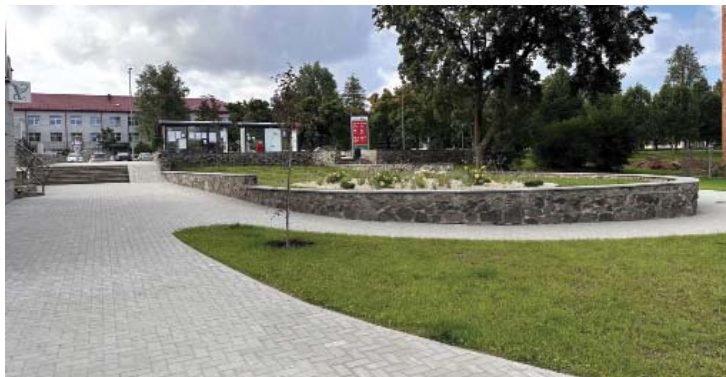
Vytauto g. skveras PO rekonstrukcijos
