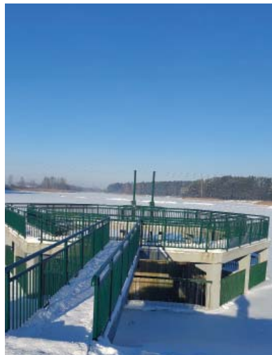
Suremontuotas Kadrėnų k. hidrotechnikos statinys
