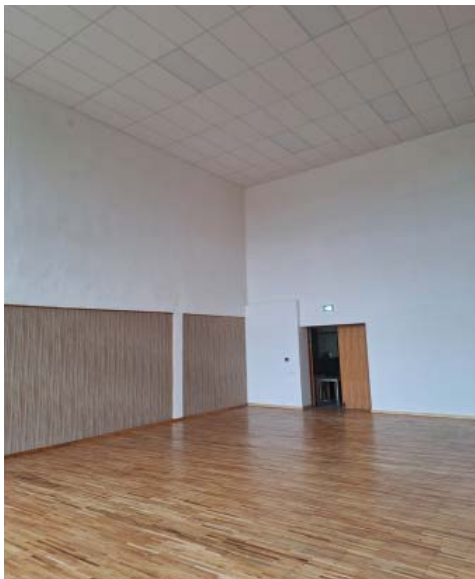
Siesikų kultūros namų salės remonto darbai
