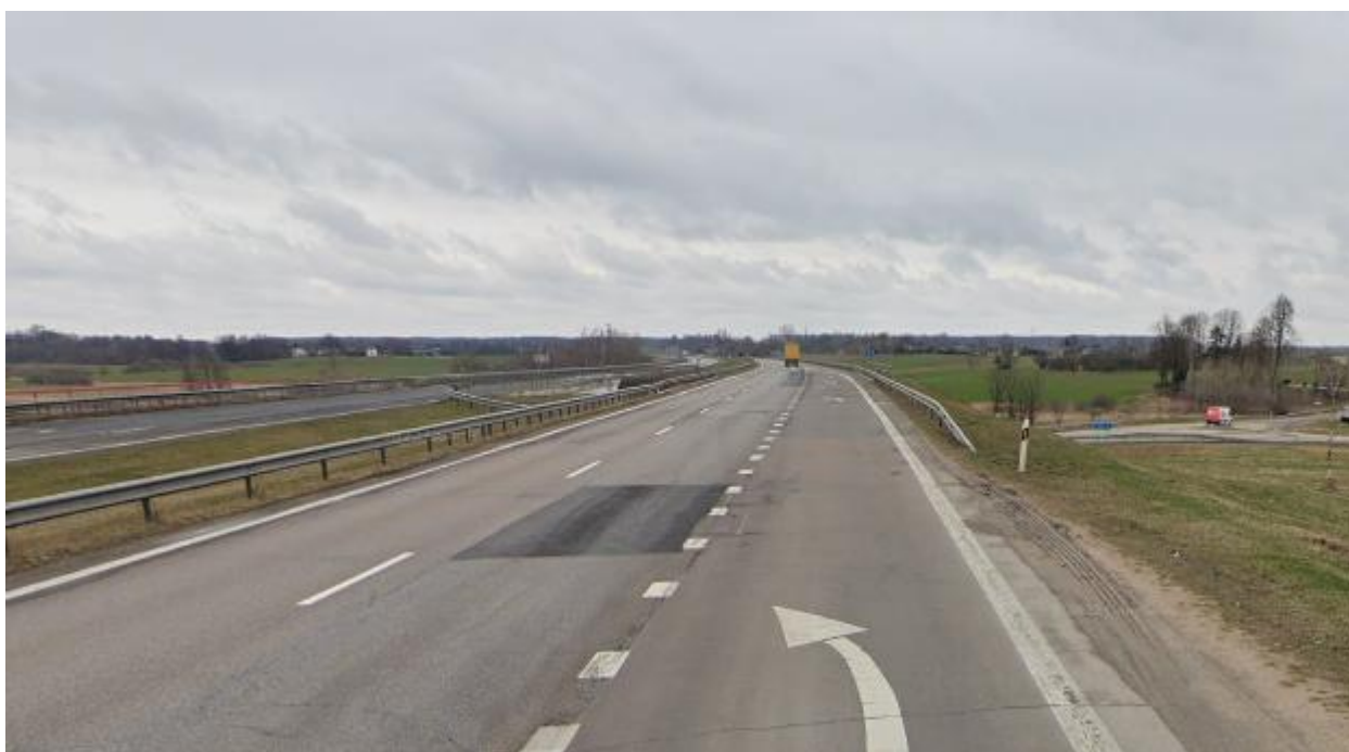
7 pav. Objekto vieta (vaizdas į projektuojamą viaduką)
