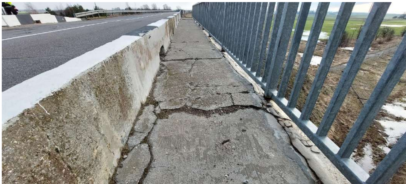
Pav. 4 Šalitilčio danga sutrūkinėjusi ir ištrupėjusi
