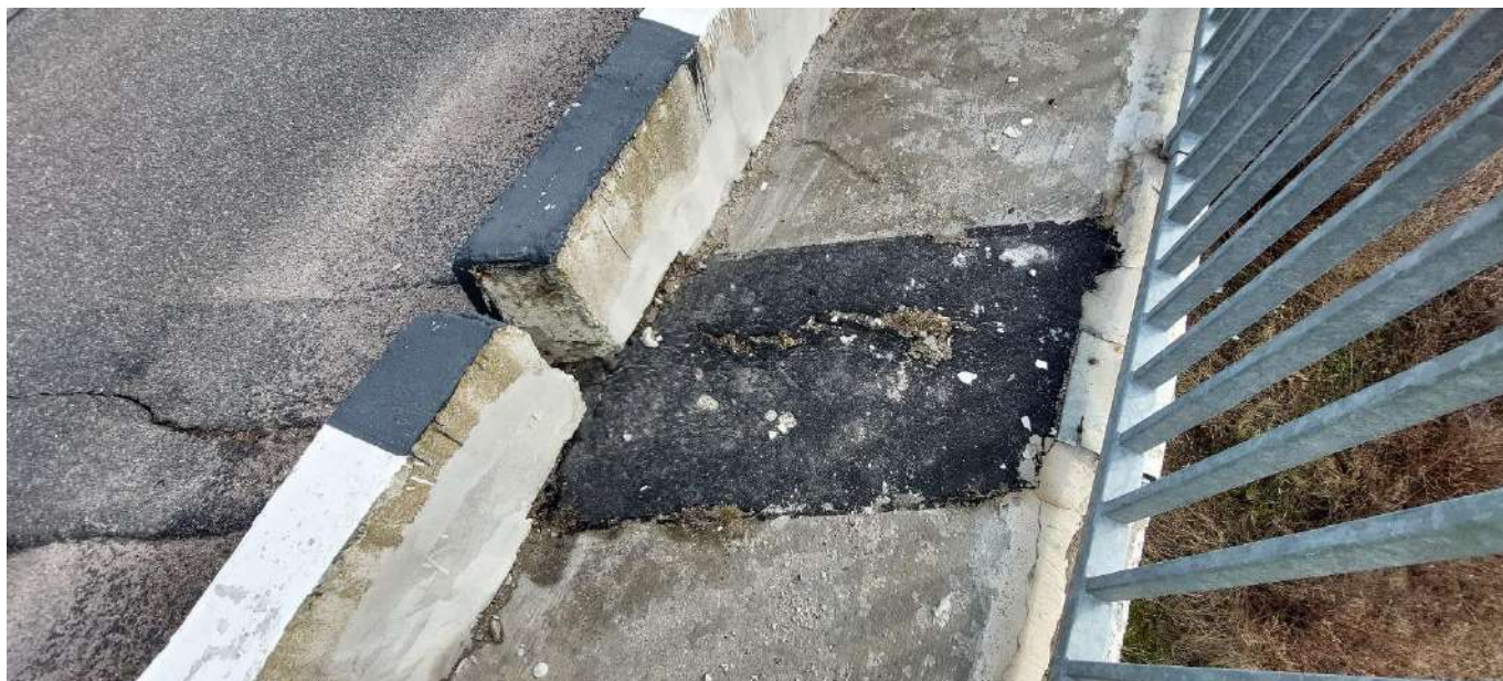
Pav. 2 Deformacinis pjūvis sutrūkinējis ir kiauras
