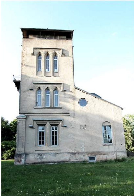
Bokšto PV fasadas
