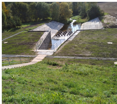
Hidrotechnikos statinys (užtvanka) ant Armonos upės Dovydiškių k.
